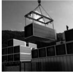
Modular Building (모듈러 건축)
