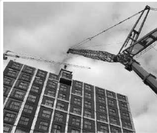
모듈러 유닛 설치
