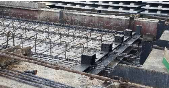
4. 철근 및 부속물 설치
