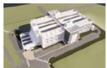
PUS04 MS 데이터센터 2018~2020 연 면 적 : 28,000㎡ 규 모 : 4F 업무범위 : Design-Build 발 주 처 : 현대건설+KT
