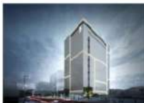
Actis 영등포 데이터센터 2021~현재진행중 연 면 적 : 26,648㎡ 규 모 : B4F~10F 업무범위 : 설계&시공BIM 발 주 처 : 현대건설
