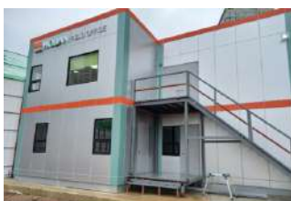
〈OSC 사례: 가설사무실 모듈러(왼쪽), 지하주차장 PC 설치(오른쪽) 사진〉
