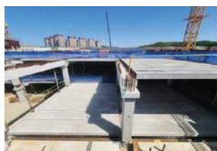
〈OSC 사례: 가설사무실 모듈러(왼쪽), 지하주차장 PC 설치(오른쪽) 사진〉
