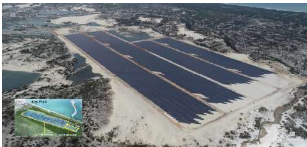
〈베트남 광빈성 Le Thuy 태양광발전사업 EPC공사〉
