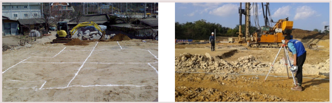
그림 15. 전통적 방식의 터파기와 측량
