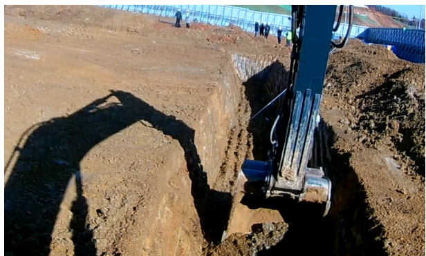
MG 관로 터파기
