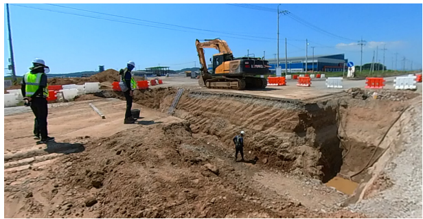
관로 터파기 작업 시작 구간
