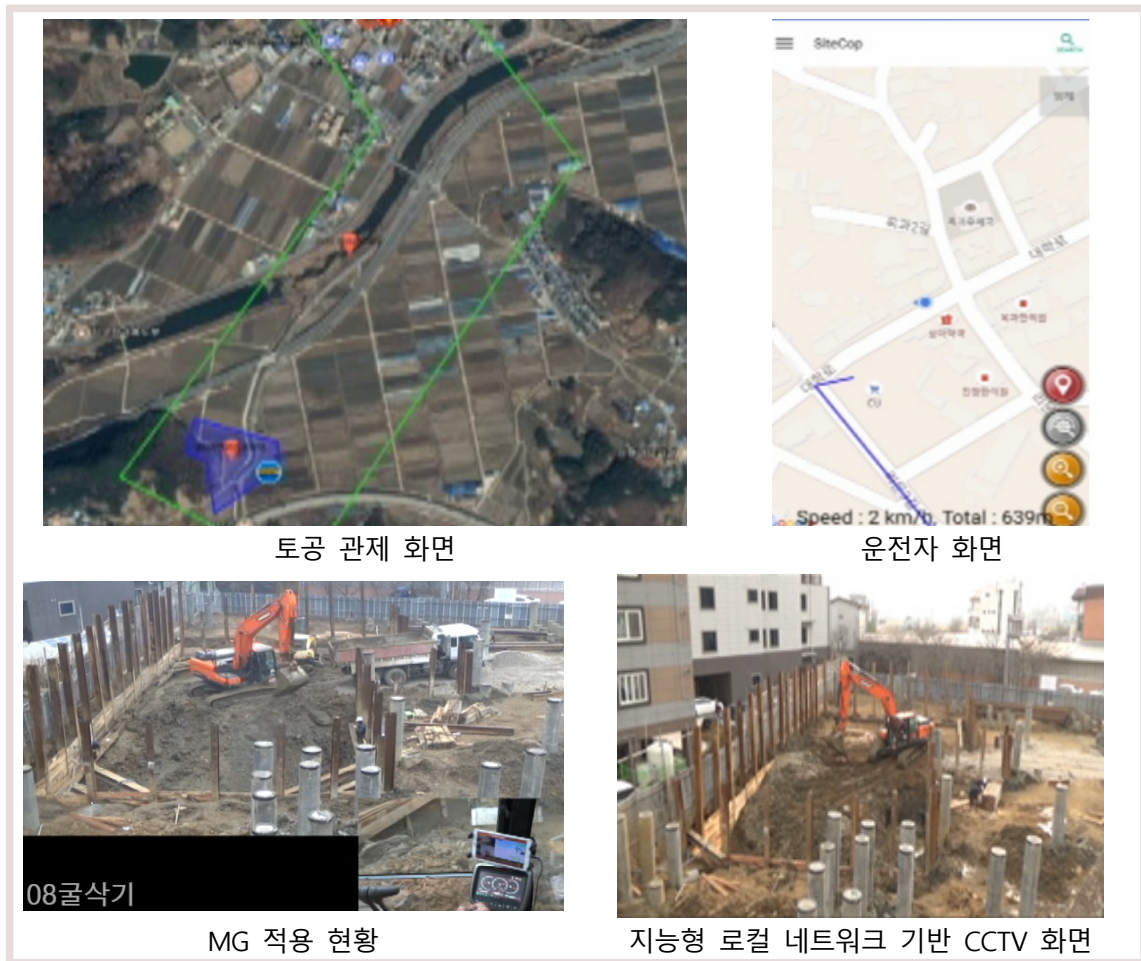
그림 56. 곡성 주상복합 현장 ICT 토공 적용 사진
