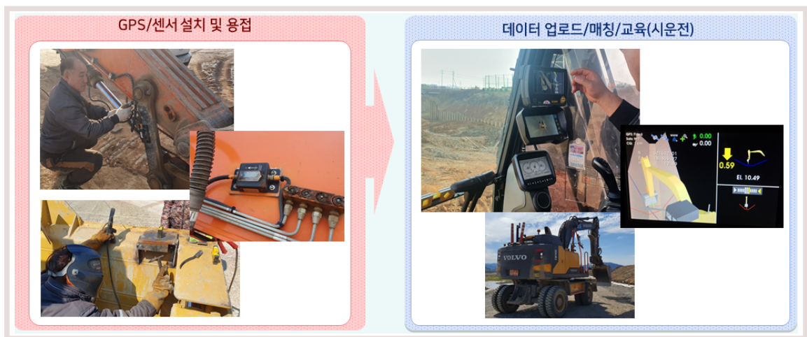
그림 21. ICT 토공 터파기 절차 중 장비설치-데이터업로드-교육 예시
