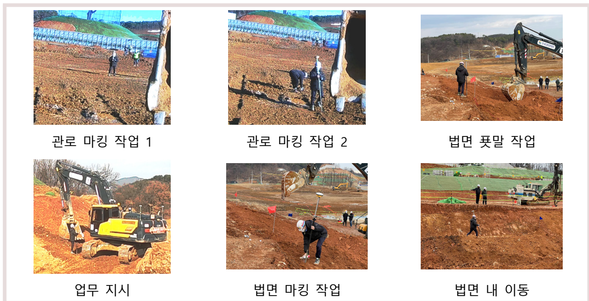
그림 35. MG 대비 기존 굴착 방식의 생산성 저해 요인
