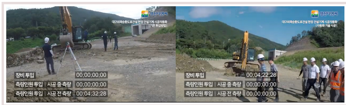
그림 47. 비교 시공 현황
