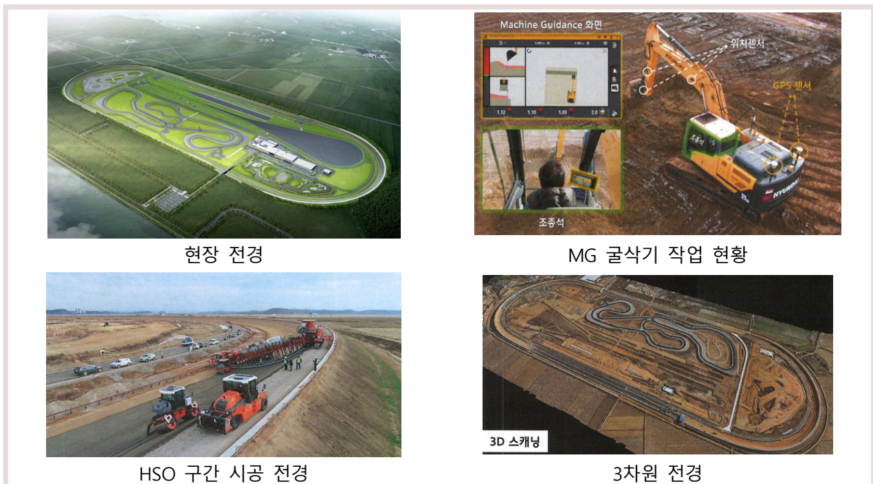
그림 29. 한국타이어 Main P/G 건설공사 MG 현장 적용 전경
