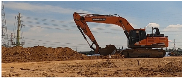
70미터 관로 터파기 작업(확인 측량사 개입 없음)
