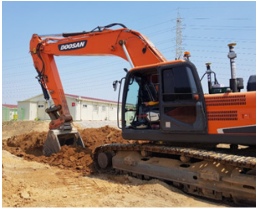
MG 굴삭기 관로 터파기
