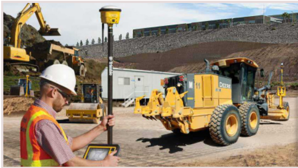
그림 13. 트림블 MG (출처: Trimble Earthwork solutions)
