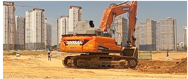
관로 터파기 작업 시작 구간
