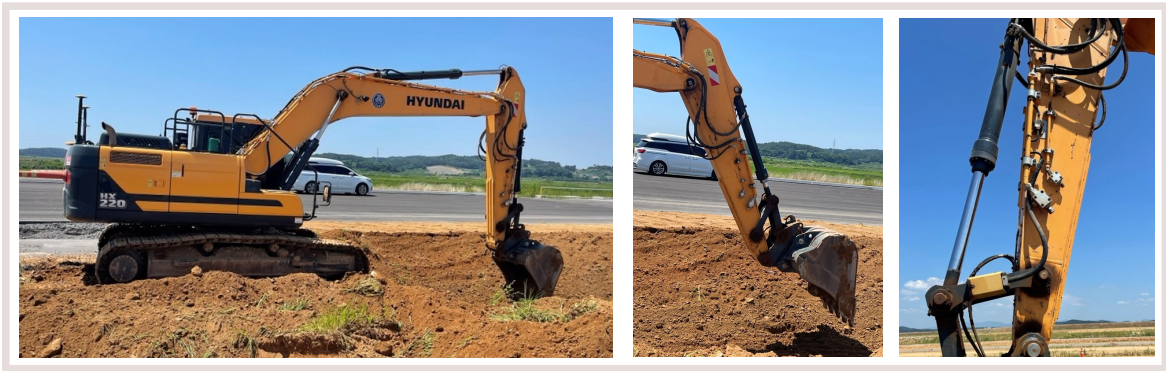
그림 22. ICT 토공 터파기 작업 예시
